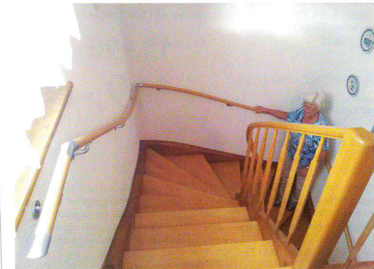
innen schmale Stufen, daher zweiter Handlauf außen
