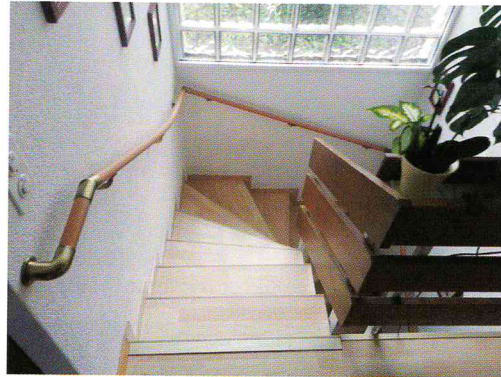
Innen schmale Stufen, sicher durch Handlauf
